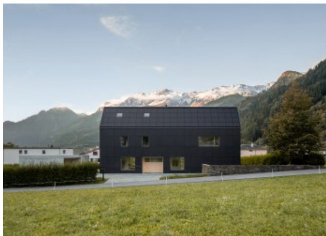
© Nadia Vontobel Architekten GmbH
