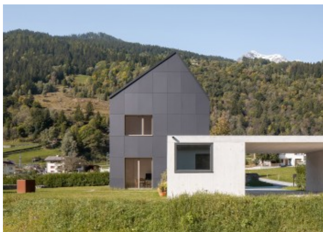
© Nadia Vontobel Architekten GmbH
