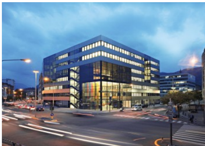
I moduli si affacciano su una strada molto trafficata © Arch. Wolfgang Simmerle
