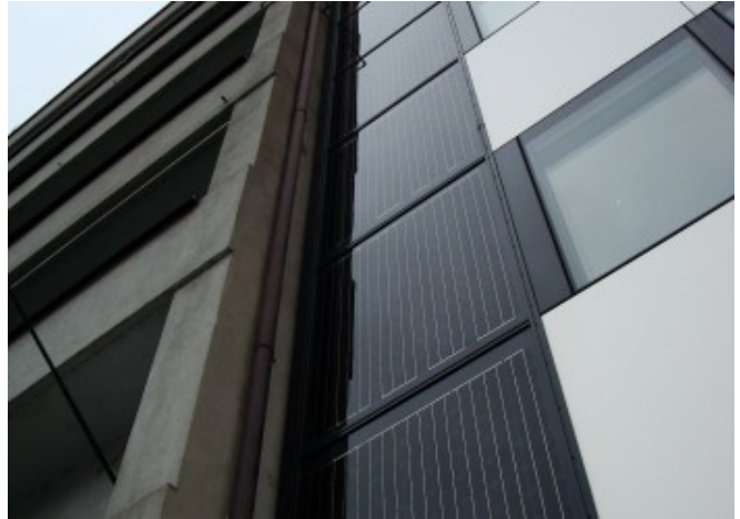
Das dunkle Photovoltaik-Band trennt die moderne Handelskammer von den angrenzenden Gebäuden © Eurac Research
