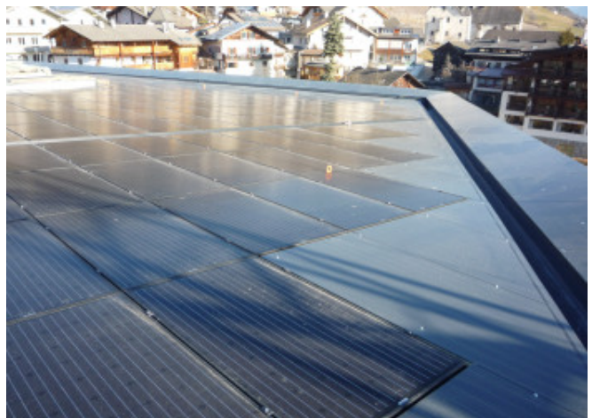
Die Füllmodule wurden montiert, um die Oberfläche der BIPV-Anlage zu ergänzen © Arch. Albert Colz
