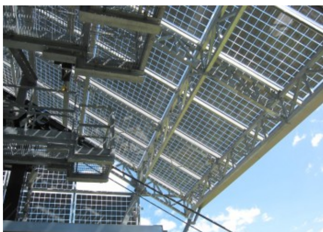
Sistema di travi reticolari in acciaio a sostegno della copertura BIPV © Leitner Electro Srl
