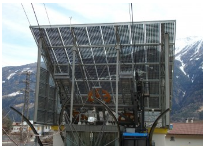
Copertura vetrata semitrasparente del corpo a valle © Eurac Research
