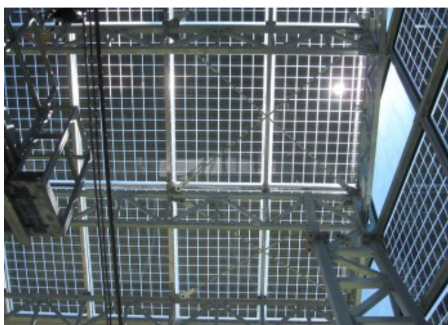
Vista di dettaglio della struttura di montaggio dei moduli in vetro © Leitner Electro Srl
