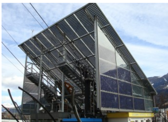
Le coperture delle due stazioni della funivia hanno un'inclinazione ottimale (30°) per l'integrazione di moduli fotovoltaici (30°) for the photovoltaic integration © Eurac Research
