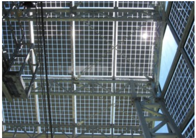
Detailansicht der Gerüststruktur © Leitner Electro Srl
