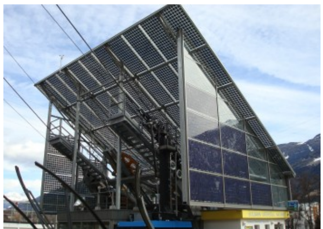
Das Dach der Seilbahnstation hatte eine optimale Neigung (30 °) für die Integration von Photovoltaikmodulen © Eurac Research
