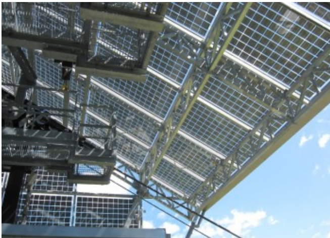
Die Stahltraversen, die BIPV-Anlage stützen © Leitner Electro Srl
