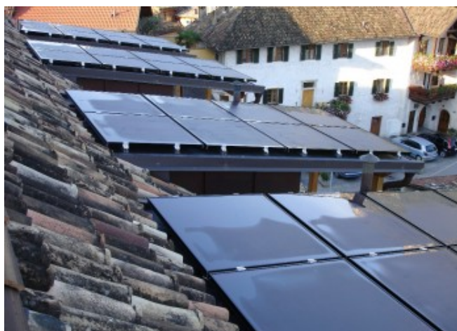
Il sistema BIPV è solo leggermente inclinato: in caso di nevicate è necessario prestare la massima attenzione © proprietario edificio
