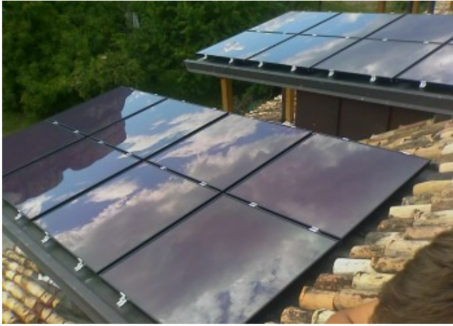
Die Module haben einen gewissen Abstand von den Blechplatten der Gauben © PVEnergy
