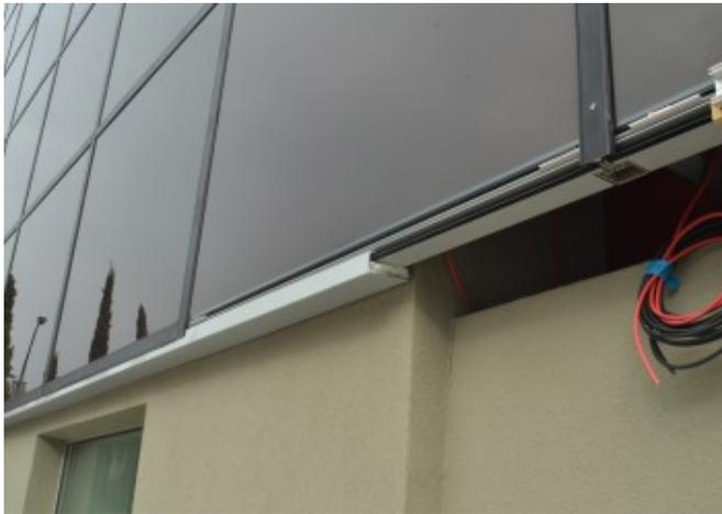
Vista ravvicinata della struttura di montaggio dei moduli © Schüco International Italia Srl
