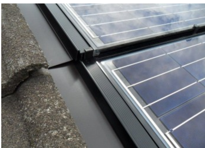
Vista dettagliata del sistema di montaggio "Solrif" © Ing. Studio Blasbichler Srl
