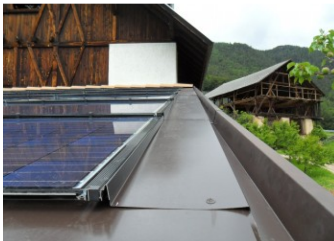
La moderna tecnologia BIPV è integrata in un contesto tradizionale © Ing. Studio Blasbichler Srl
