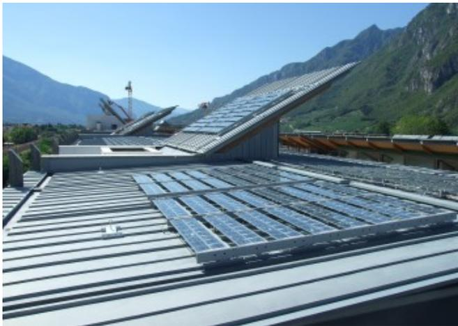
Moduli in vetro-Tedlar (a) montati su profili metallici fissati alle lamiere di copertura degli edifici © FAR System Srl
