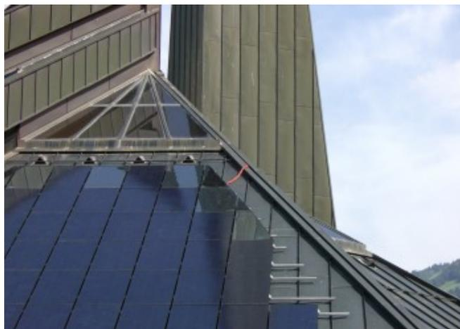
Fase di costruzione: sono ancora visibili il tetto metallico della chiesa e il sistema di montaggio del sistema BIPV © Eurac Research
