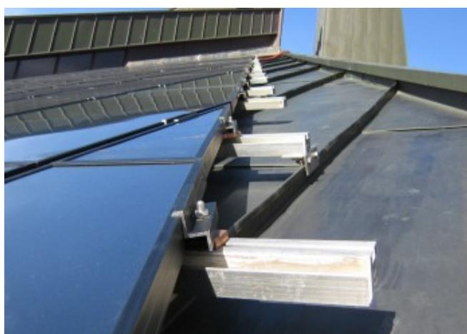
Vista ravvicinata della struttura di fissaggio dell'impianto BIPV © Eurac Research
