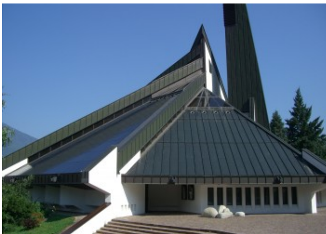
Blick auf die ursprüngliche Blechdachoberfläche, nicht so unterschiedlich von den PV-Modulen © Eurac Research
