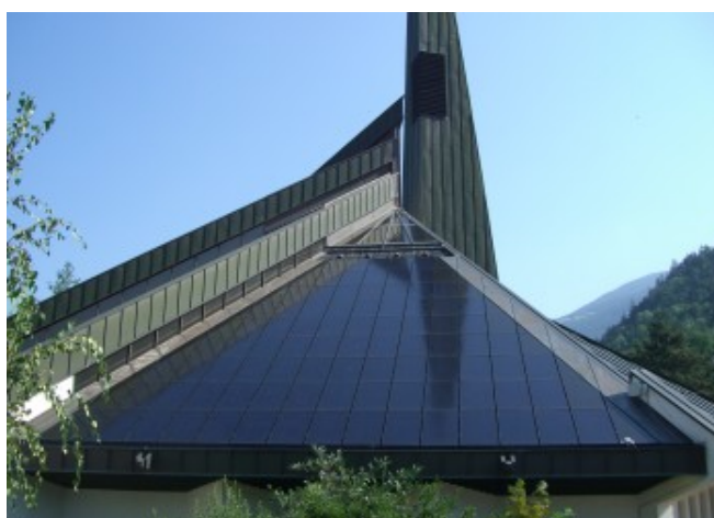
Endgültige Füllmodule installiert, Übereinstimmung mit der Oberfläche der BIPV-Anlage © Eurac Research
