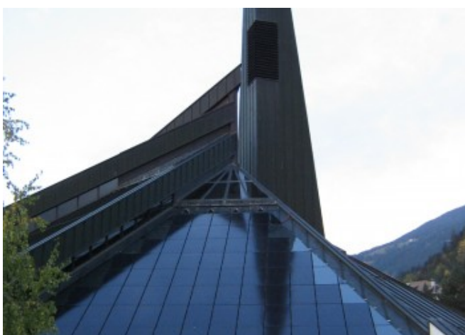
Erste Füllmodule installiert, zu stark reflektierend © Eurac Research
