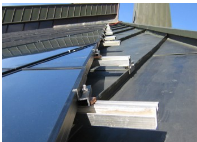
Detailansicht der BIPV-Befestigungsstruktur © Eurac Research
