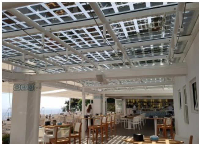
Die BIPV-Module spenden Schatten auf der Terrasse © GruppoSTG Srl
