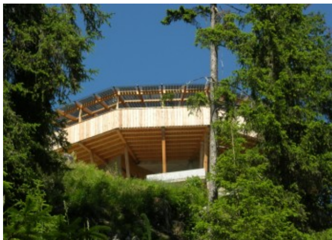
La tettoia fotovoltaica sospesa sul pendio boscoso © Augustin Clement
