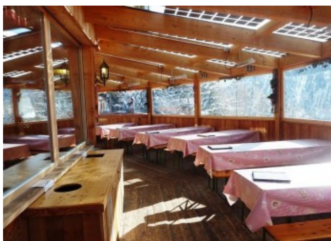
Effetto ombreggiante della tettoia BIPV © Augustin Clement
