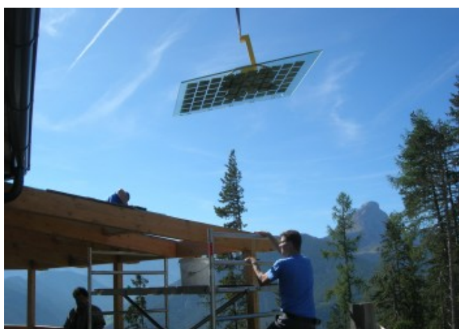
Fase di costruzione: i moduli senza cornice sono montati con facilità © Augustin Clement
