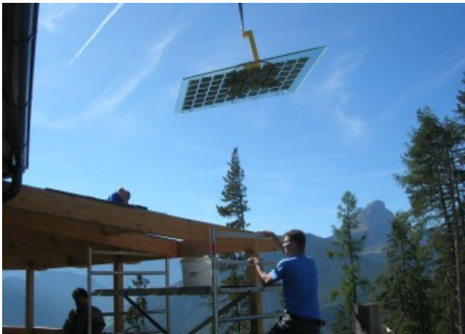
Bauphase, die rahmenlosen Module können leicht montiert werden © Augustin Clement
