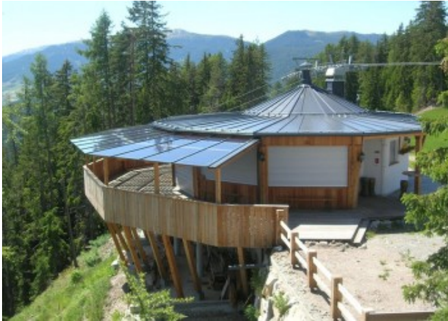
Das Gebäude ist in die natürliche Umgebung von Piz de Plaies eingebettet © Augustin Clement
