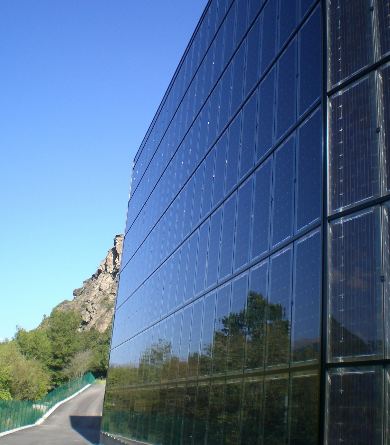
Centrale di teleriscaldamento di Laces
