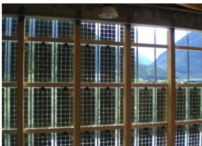
Vista dall'interno dell'edificio: sono visibili la struttura di supporto in legno e la semitrasparenza dei moduli © Günther Wallnöfer
