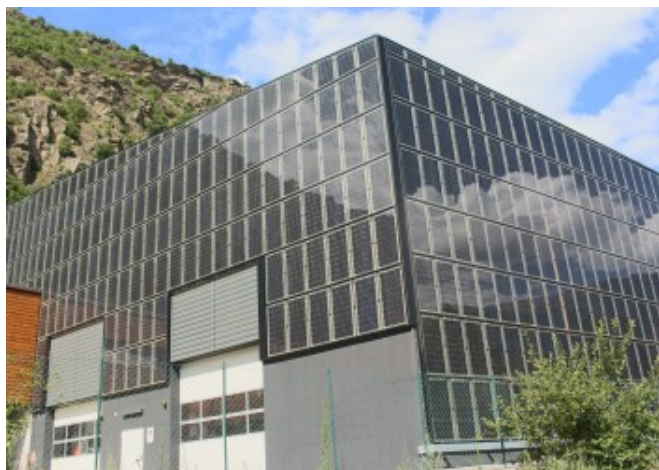
L'impianto BIPV copre le pareti opache con una facciata ventilata che genera un effetto camino © Eng. Klaus Fleischmann
