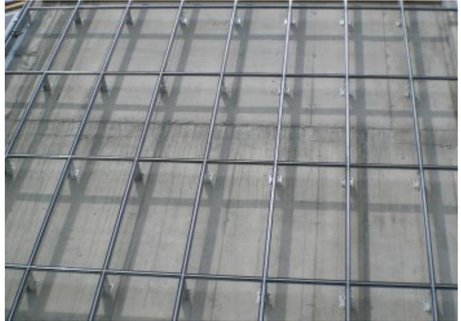
Das Stahlträgersystem der Module vor einer lichtundurchlässigen Außenwand des Gebäudes © Günther Wallnöfer
