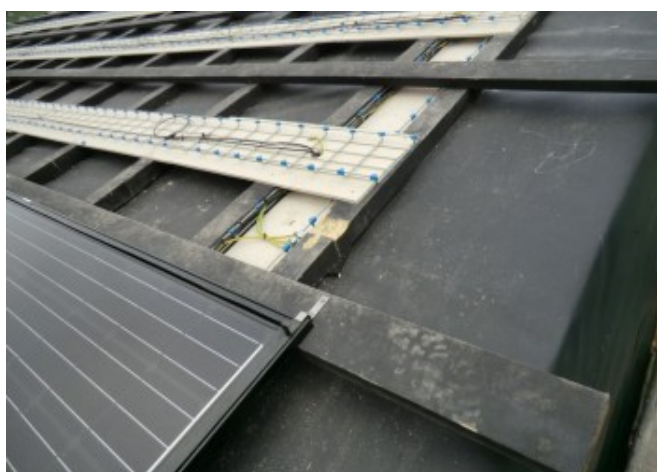
Vista dettagliata del sistema di montaggio "Solrif" © Leitner Electro Srl
