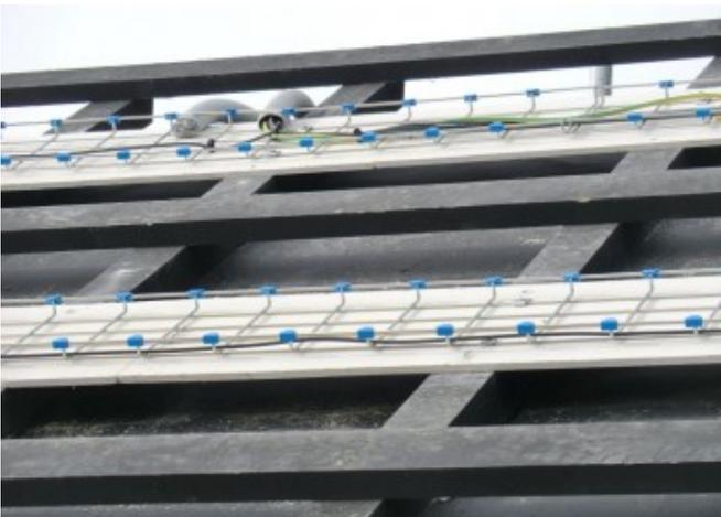
Hölzerne Modul-Unterstruktur: Die Kabel und die feuerfesten Gipskartonplatten sind sichtbar © Leitner Electro Srl
