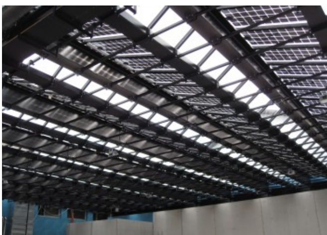
Vista dettagliata della struttura di sostegno del sistema BIPV © Colterenzio Winery
