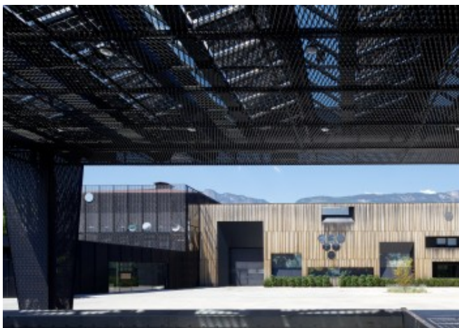
Integrazione di diversi materiali e strutture © Günter Richard Wett
