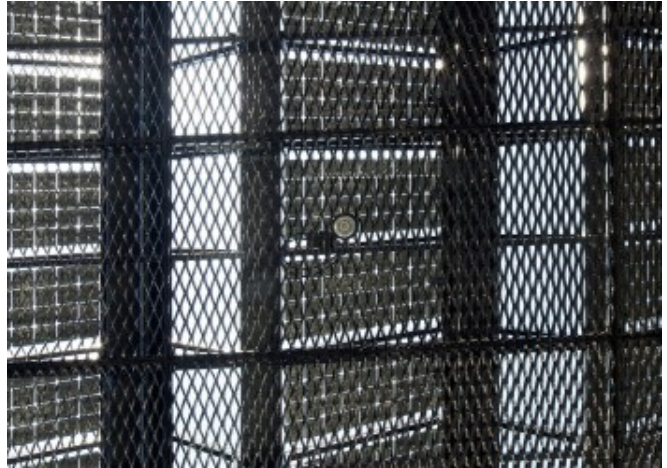
Ansicht des Photovoltaik-Glasdachs und des darunter befindlichen schwarzen Aluminiumgitters © Günter Richard Wett
