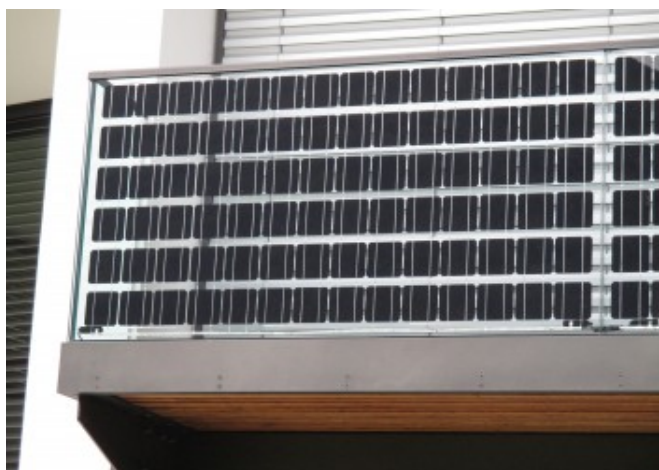
Le celle FV proteggono parzialmente le ampie finestre dagli sguardi esterni © proprietario edificio
