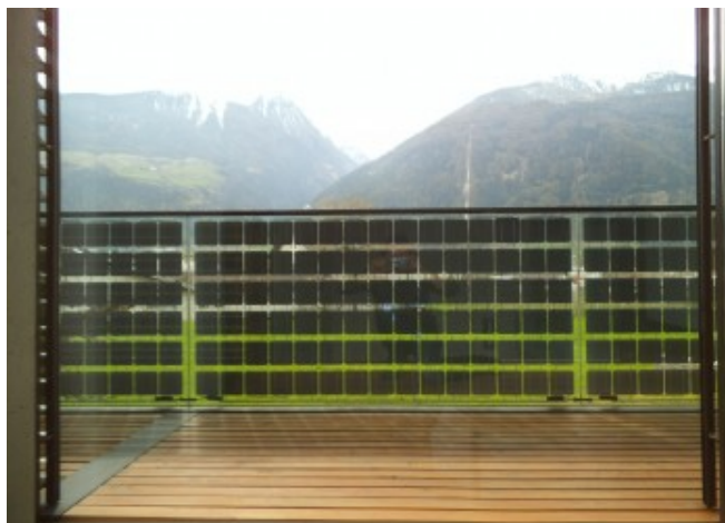
Il parapetto semitrasparente consente la vista del paesaggio circostante © proprietario edificio
