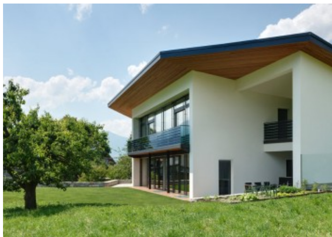
Vista dei due parapetti fotovoltaici © proprietario edificio
