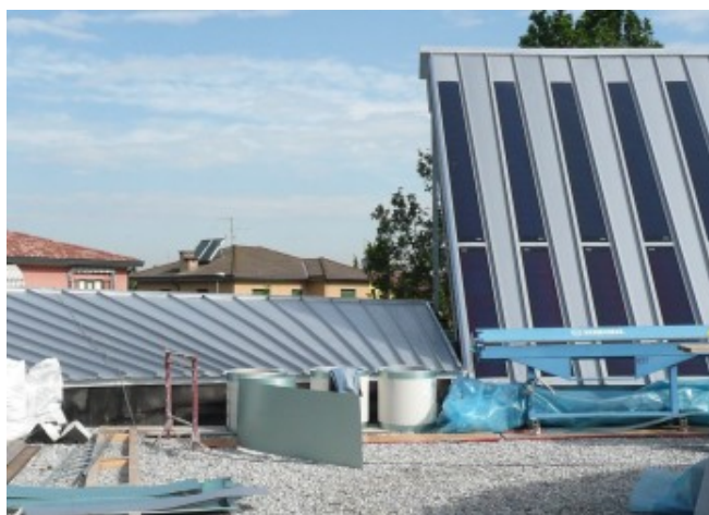
Particolare della fase di montaggio della copertura
