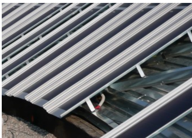
Particolare della fase di montaggio della copertura
