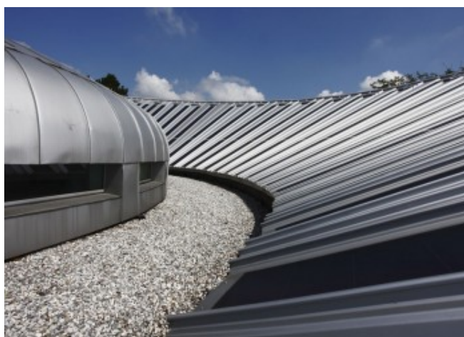
Vista parziale della copertura metallica
