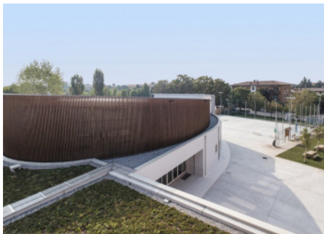
Dal cortile interno si nota il cavedio compreso tra la doppia pelle della sala della comunità
