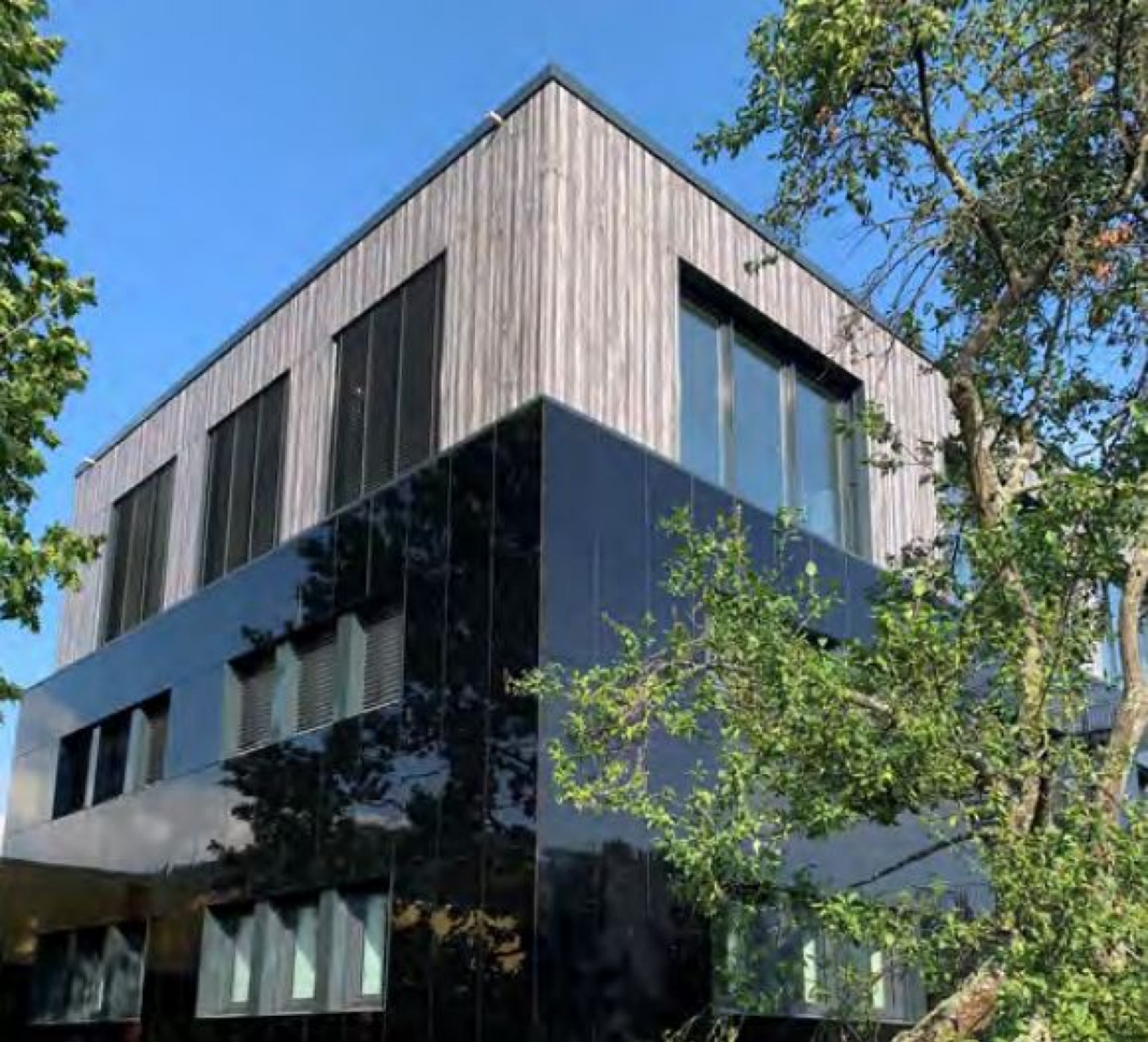
Edificio per uffici a Miltenberg
