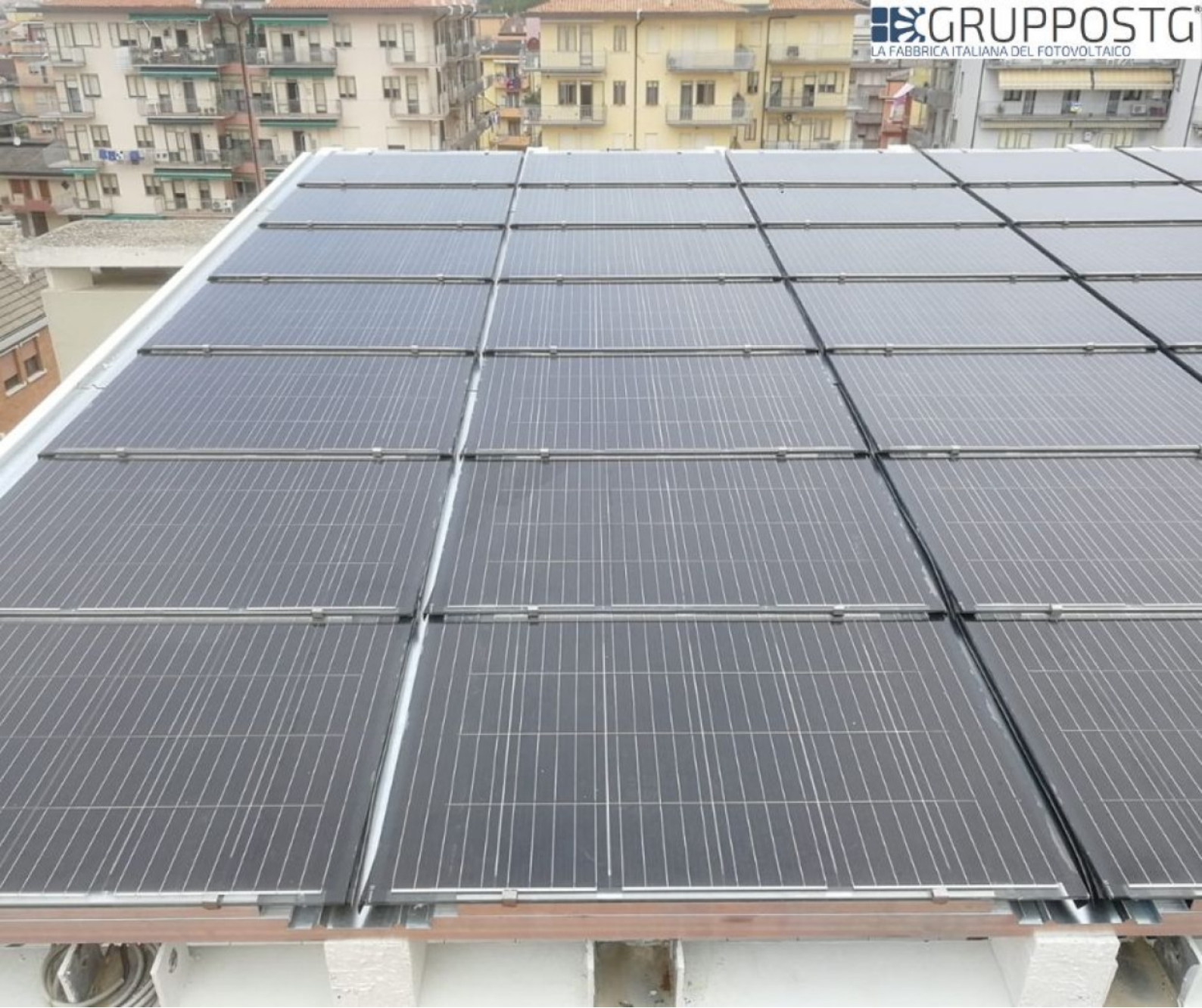
Wohnhaus in Chioggia
