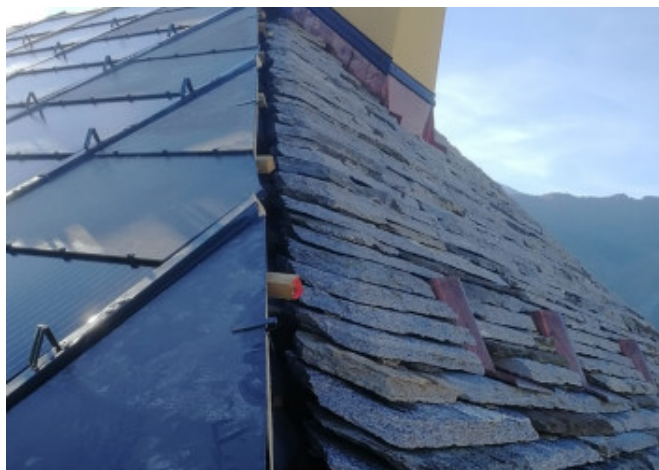
Dettaglio modulo per integrazione su tetto storico
