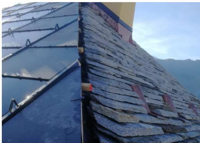
Dettaglio modulo per integrazione su tetto storico
