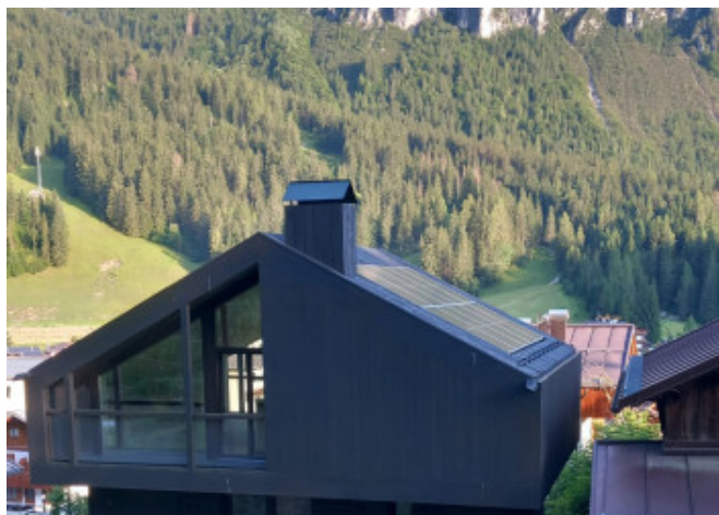
Sistema fotovoltaico integrato in falda
