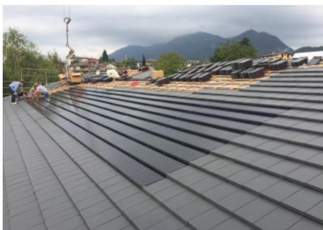
Posizionamento delle tegole intorno alla porzione BIPV © marco minelli architetto
