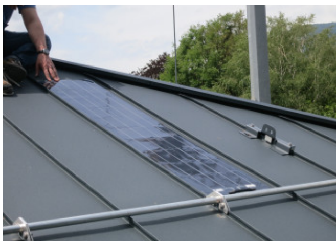
In die Bedachung integrierte Solbian-Photovoltaikmodule © Arch. Valentina Cari
