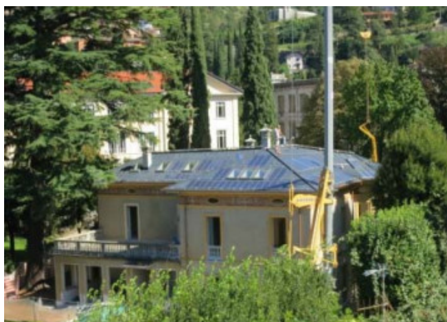
Das Gebäude nach der energetischen Sanierung © Arch. Valentina Cari
