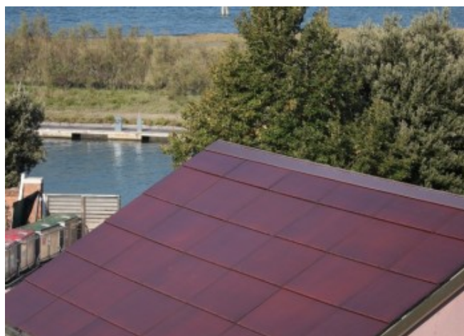
Edificio con tegole fotovoltaiche e laguna di Venezia sullo sfondo
