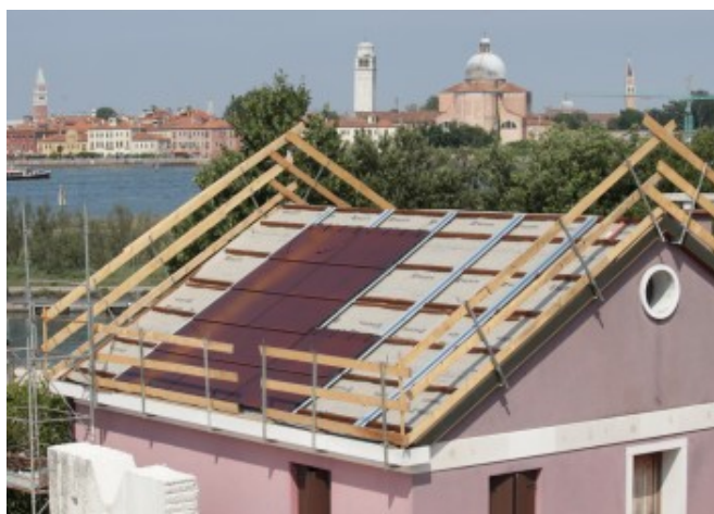
Posa delle tegole fotovoltaiche a sostituzione delle tegole in cotto
