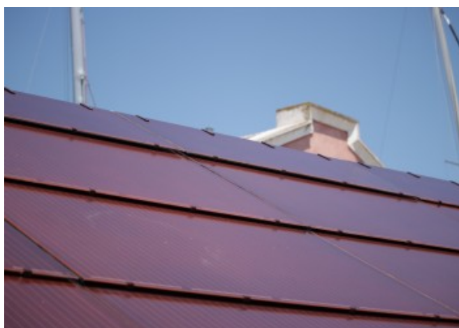
Sovrapposizione delle tegole fotovoltaiche
