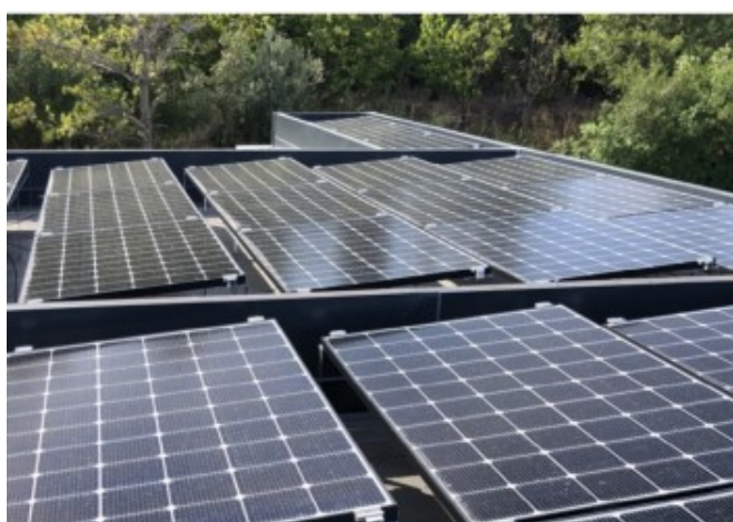
Positionierung der BIPV-Module auf dem Vordach © Noemi Fabiano
