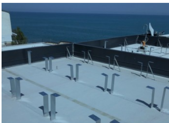
Modulbefestigungssystem auf dem Vordach © Noemi Fabiano
