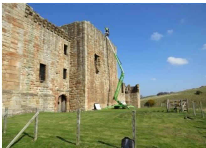
Montage von Photovoltaikmodulen mit der Hilfe eines Krans © Historic Environment Scotland
