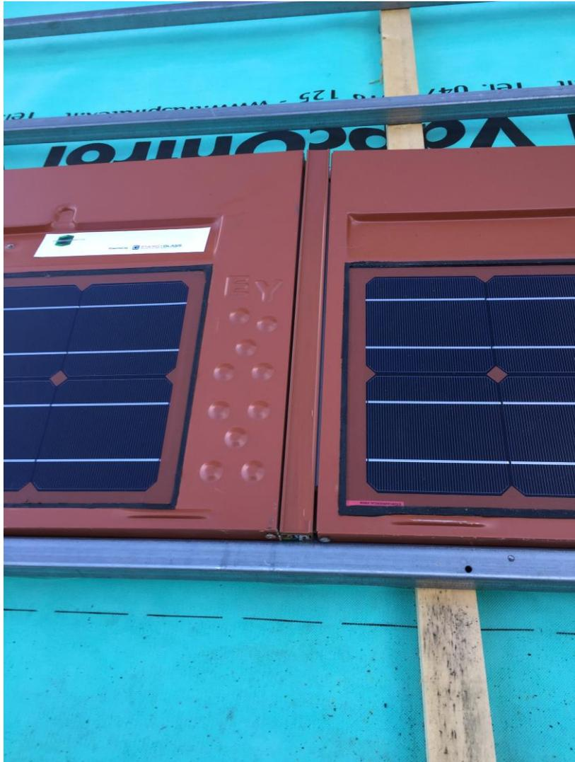
FIGURA 18 ALLINEAMENTO E RACCORDO COMPLETATI
