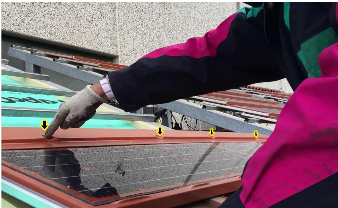
FIGURA 7 INDICAZIONE DELLE ASOLE DI FORATURA PER INTERASSI "D" PIU' ESTESI
