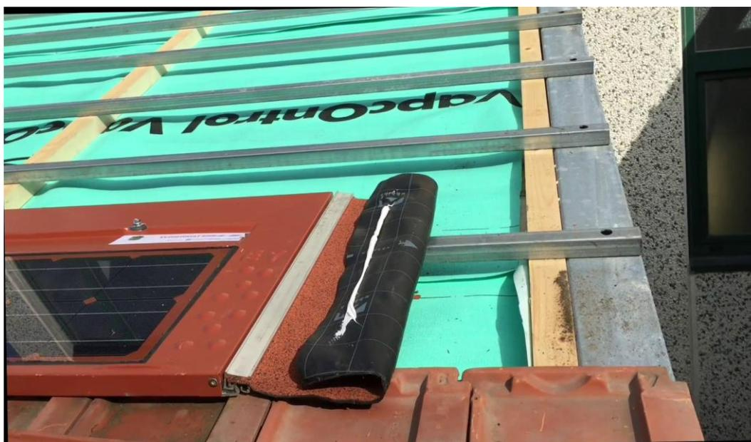
FIGURA 13 POSA ULTIMATA DEL SILICONE LUNGO L'ELEMENTO DI RACCORDO
