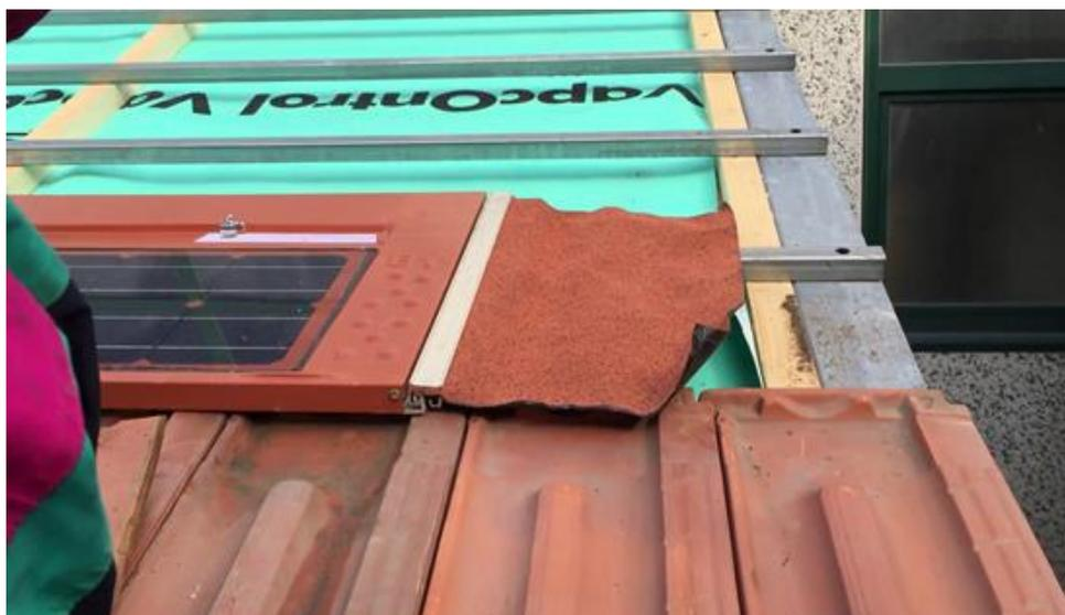
FIGURA 11 INSERIMENTO ELEMENTO DI RACCORDO ULTIMATO
