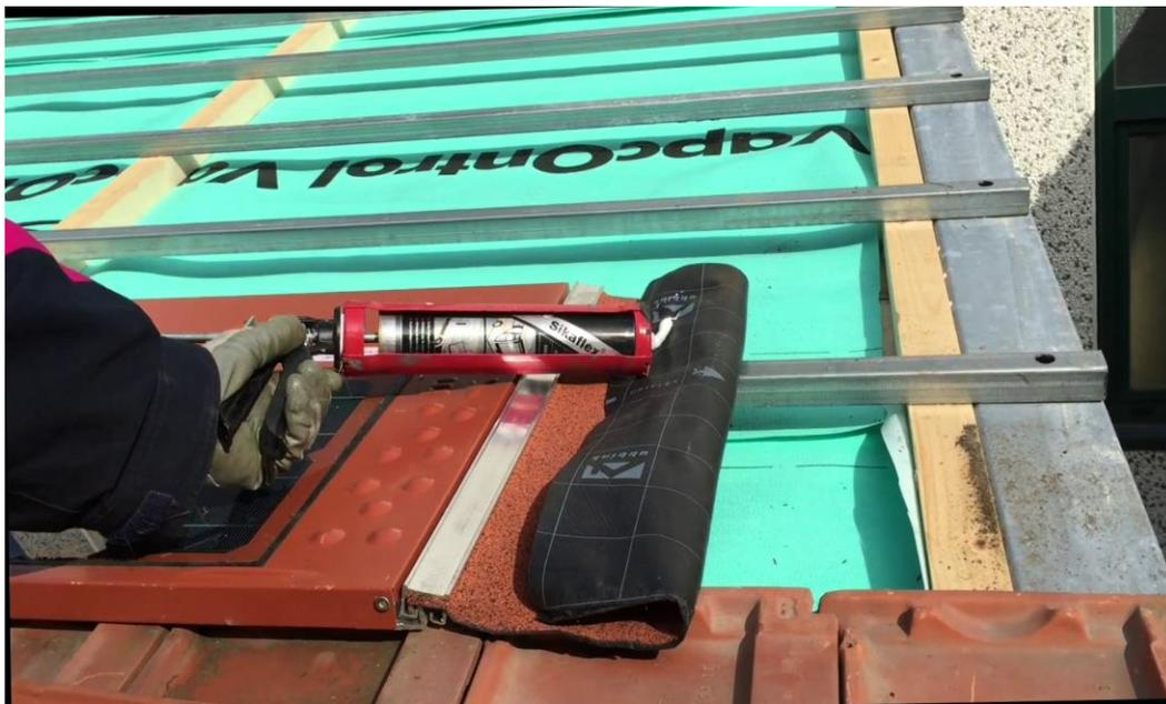
FIGURA 12 PREDISPOSIZIONE DEL SILICONE SOPRA ELEMENTO DI RACCORDO
