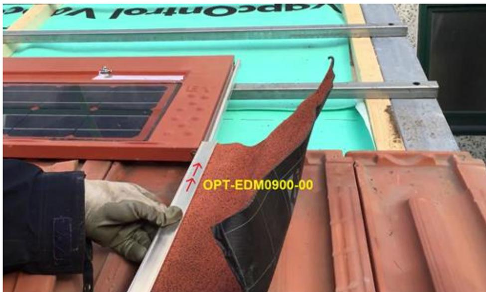
FIGURA 10 INSERIMENTO ELEMENTO OPZIONALE DI RACCORDO
