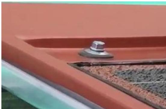
FIGURA 5 ESEMPIO DI ACCOPPIAMENTO VITE-CAPPUCCIO DI TENUTA
